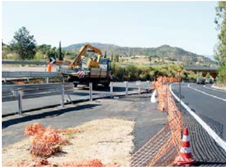
Lavori fermi sulla strada statale 125
